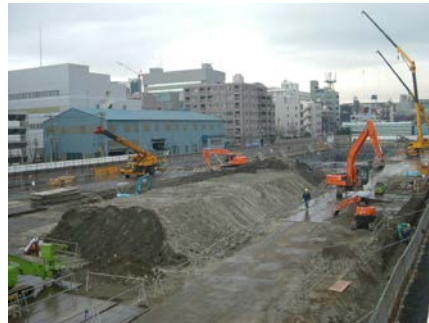
場内掘削残土の再利用
