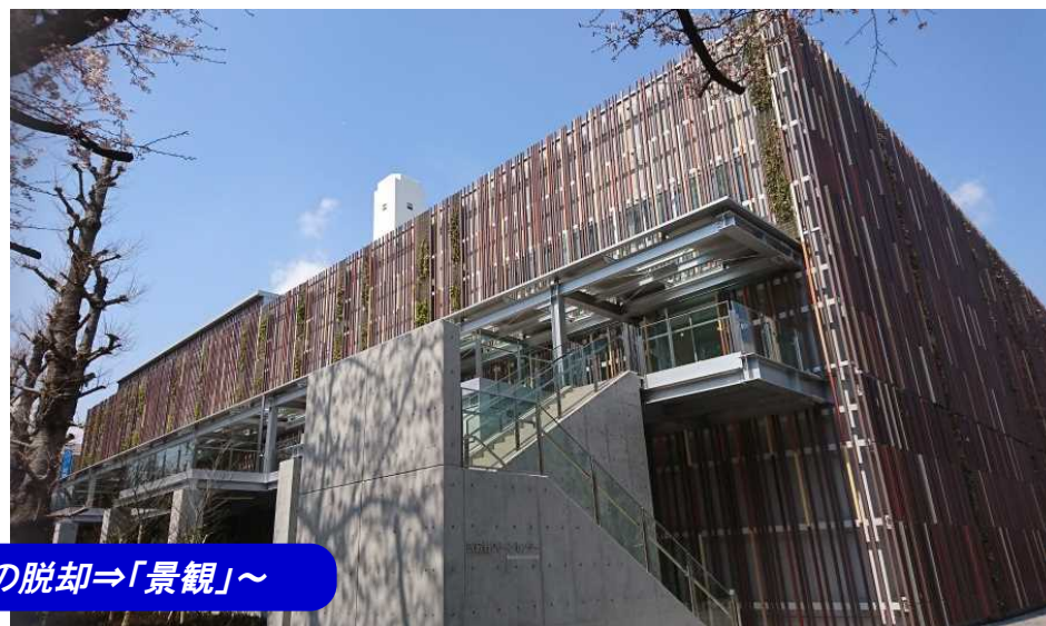
新廃棄物処理施設 建築外観(外壁デザイン:テラコッタルーバ外装・壁面緑化)
