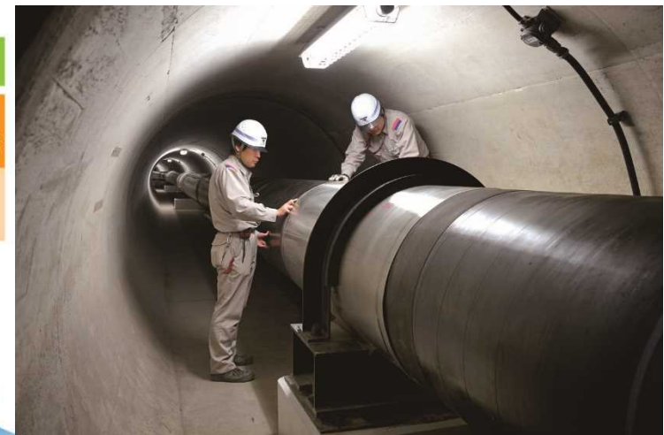
中圧ガス導管 ※東京ガス(株)より提供
