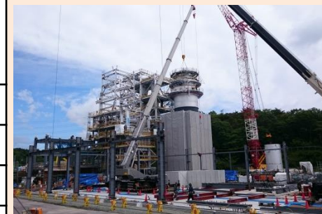
楢葉町の仮設焼却施設 (平成28年6月)
