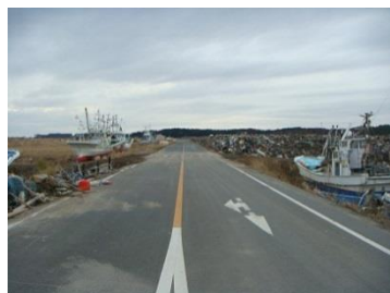
撤去前 (平成26年7月)
