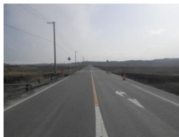
撤去後 (平成28年3月)
