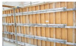
国産材を使ったコンクリート型枠
