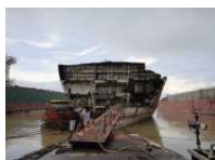
岸壁における解体 （中国）
