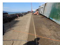
解撤場内の排水溝
