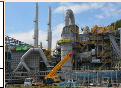
飯館村蕨平地区の仮設焼却施設 (平成27年10月)
