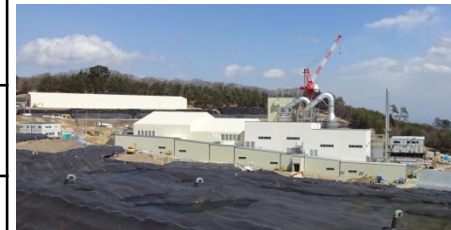
葛尾村における仮設焼却施設の建設状況(平成27年3月)
