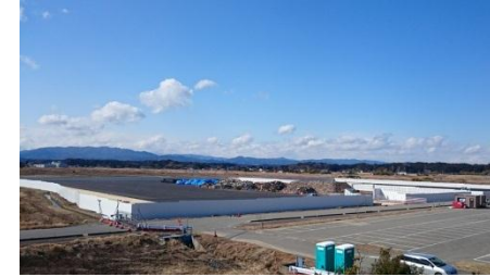
双葉町中野地区における仮置場の整備状況(平成27年3月)
