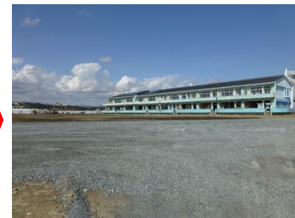
撤去後(平成27年3月)
