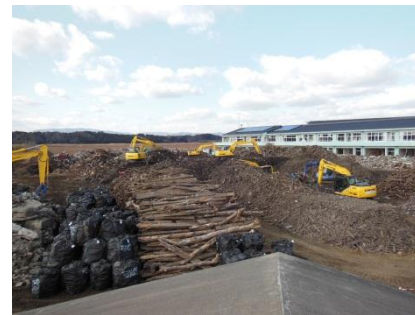
撤去前(平成26年1月)
