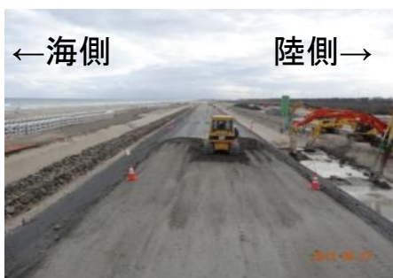
災害廃棄物を用いた盛土状況 （仙台市深沼南工区）
