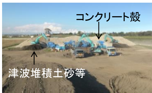
災害廃棄物改良（混合）状況 （仙台市深沼南工区）
