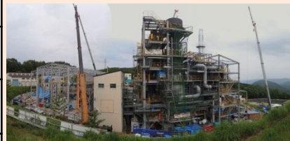
飯舘村小宮地区における仮設焼却炉の建設状況(平成26年6月)
