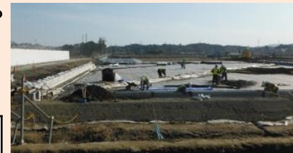
楢葉町前原地区における仮置場整備工事(平成26年4月)
