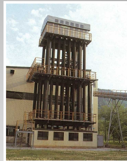
コンデンサータワー
