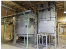
<Li-ion電池リサイクル設備>
