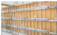
国産材を使ったコンクリート型枠
