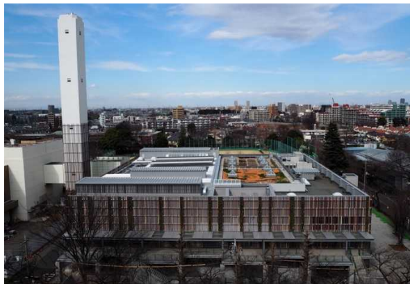
地域の防災拠点、エネルギーセンターとなる廃棄物処理施設 出典：環境省
