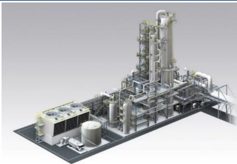
CO 2 回収実証プラント（建設中） 回収能力：500t-CO 2 /日、稼働開始予定：2020年
