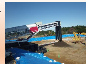
中間貯蔵施設 土壌貯蔵施設
