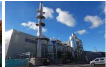
楢葉町の仮設焼却施設 出典：環境省
