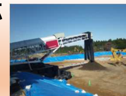
中間貯蔵施設 土壌貯蔵施設
