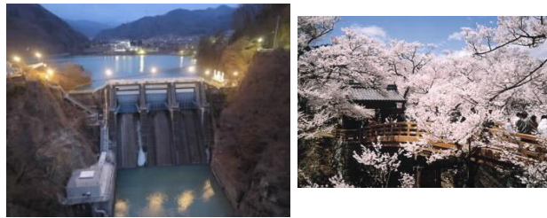
高遠さくら発電所（伊那市） （出力180kW 約350世帯分を発電）
