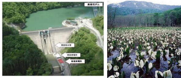
水芭蕉発電所（長野市） （出力980kW 約1,400世帯分を発電）
