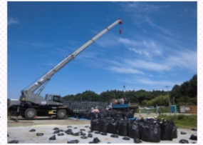
除去土壌等の搬出の様子
