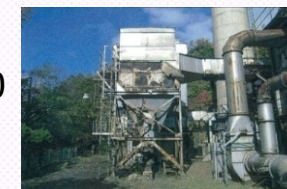
老朽化した廃棄物処理施設の更新
