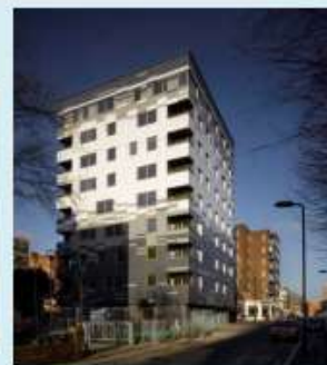
集合住宅(9F:1FはRC) (イギリス ロンドン)
