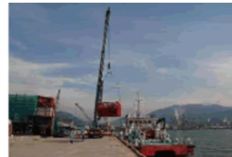
陸上クレーンによるごみコンテナ吊り上げ
