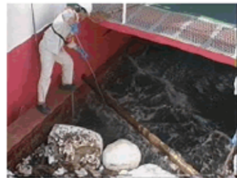
人力によるごみ回収作業
