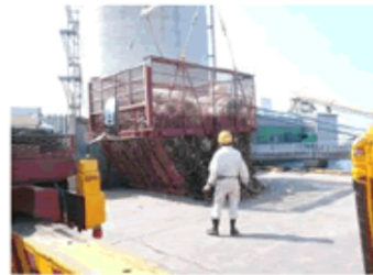
岸壁へのごみ陸揚げ
