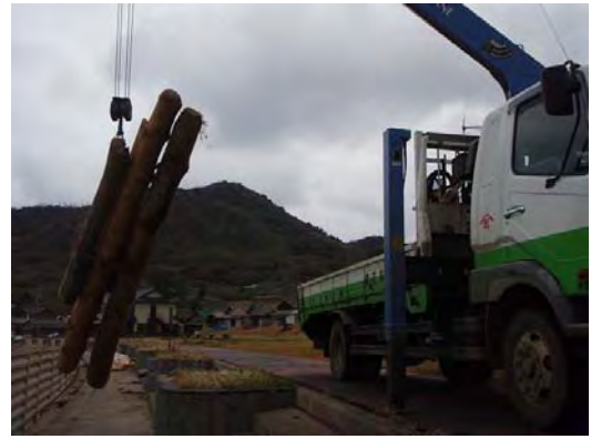
ユニックでの回収（島根県松江市）
