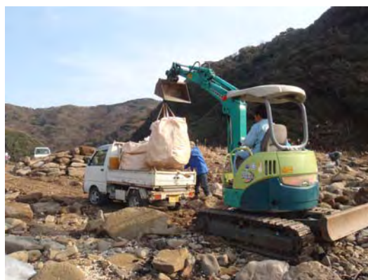
バックホウと軽トラックでの搬出 （長崎県対馬市）
