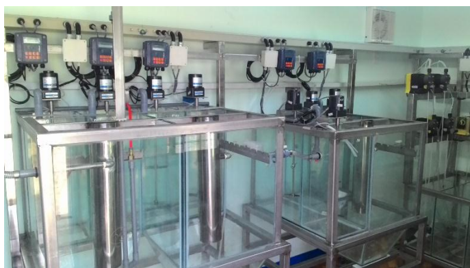
＜凝集沈殿処理：反応水槽＞
