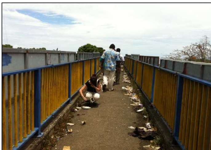
【写真1：屋外排泄に利用される歩道橋】
