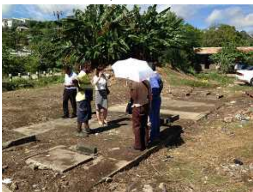
【写真18：Rove Police地区の Communal Septic Tank】
