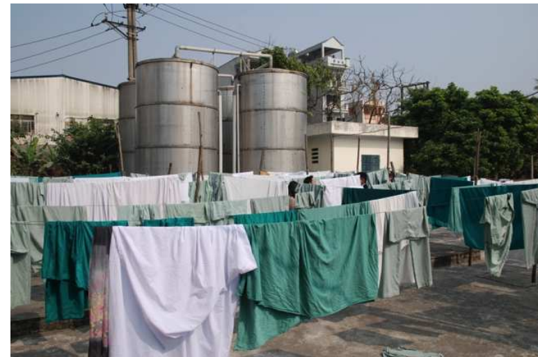
<排水処理施設(C病院と同じ装置)>
