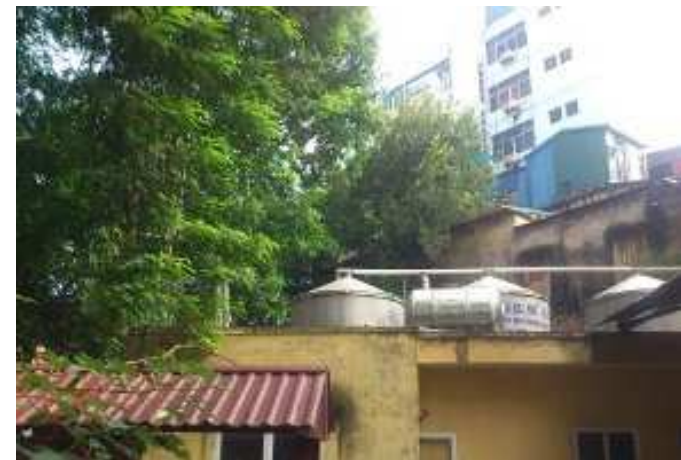
<排水処理施設>
