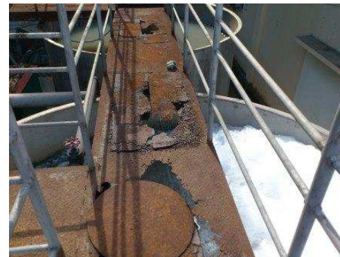
< 排水処理設備(左:“Moi Truong(環境)のために”と記された看板を掲げている)と活性汚泥処理設備タンク上部(右:通路が腐食して歩けない状況)>
