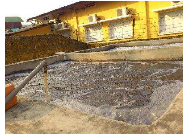
< 排水処理施設 調整・ばっ気槽 >
