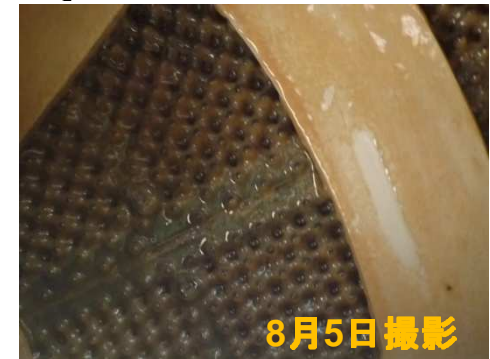
8月5日撮影 ＜回転接触体に付着した生物膜＞
