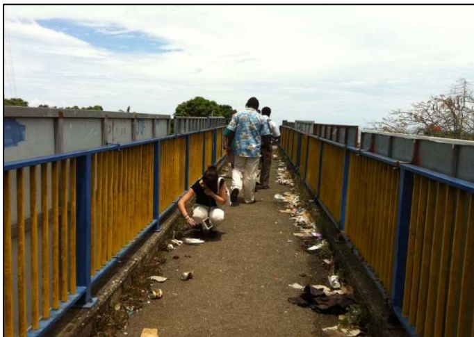
【写真1: 屋外排泄に利用される歩道橋】
