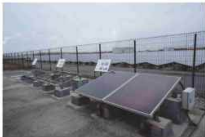
環境教育の一環としてパネルの設置工程を学ぶことができる見学スペースを設置
