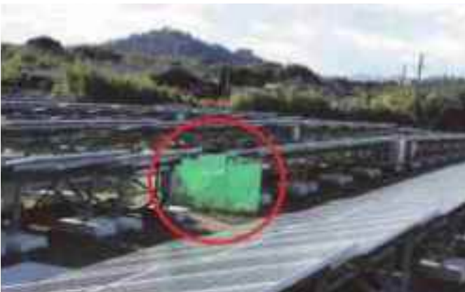
ガス抜き管等の処分場維持管理設備周辺に管理用スペースを確保
