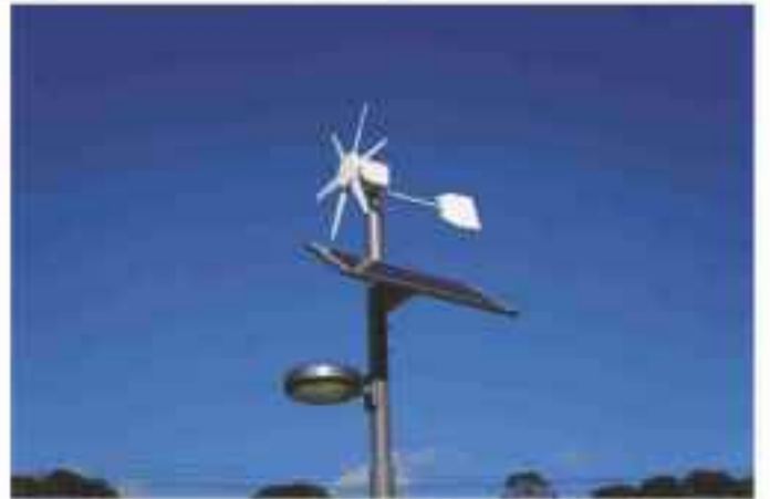
ハイブリッド防犯灯(3基)を設置
