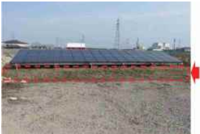
埋立物への影響を考慮し最終覆土層上部に約50cmの盛土を実施
