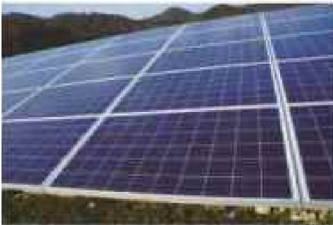
光害及びモジュール性能劣化現象に対応したパネルを採用
