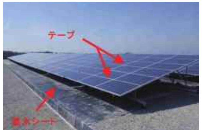
遮水シートを敷設し雨水を排水することで浸出水を抑制(浸出水抑制策2)
