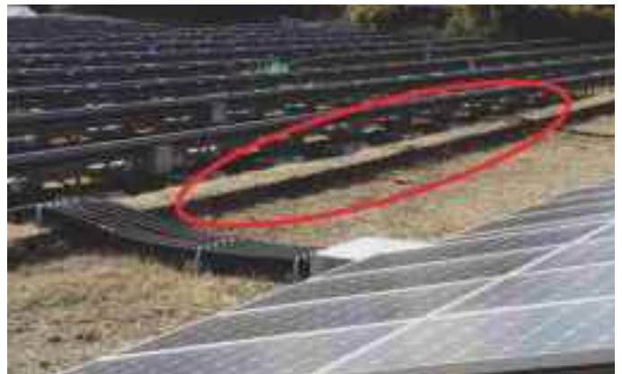
雨水による表土等の流出を防ぐため雑壇ごとに土堰堤を設置
