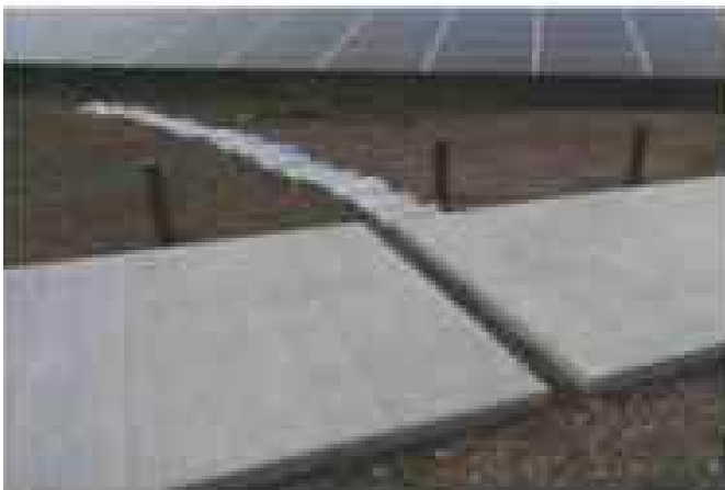
雨水排水対策のため雨水を効率よく排水路に誘導
