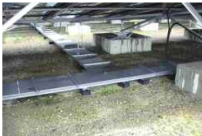
埋立物に影響を及ぼさないよう、配線の埋設を避け地表の専用ケースに格納
