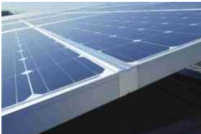
テープの貼付により雨水をアレイ下方向に集水(浸出水抑制策1)
