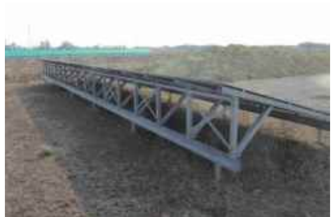
設備荷重は20kN/m 2 以下とし、設置に伴う荷重増加による処分場への影響を軽減
