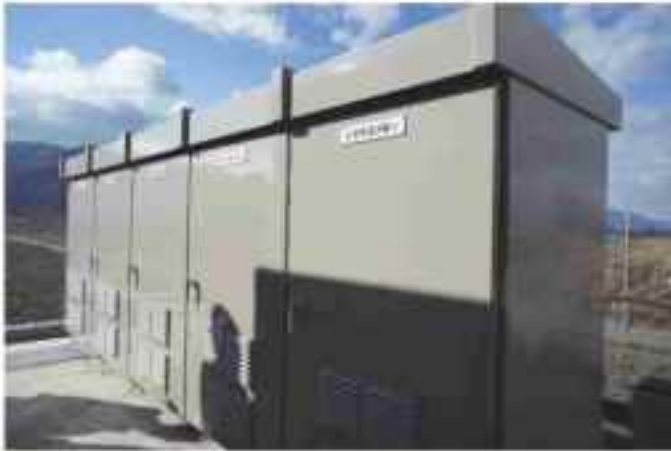
自立運転機能が付いたパワーコンディショナーを設置
