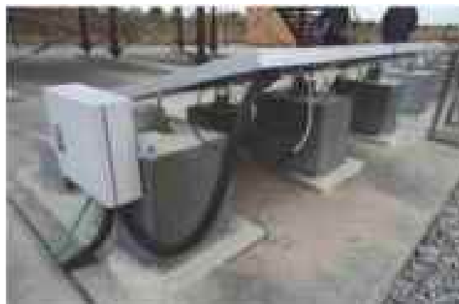
雑草繁茂対策として防草シートの敷設等を実施
