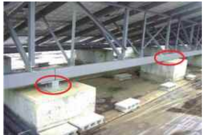
整地を行わず調整器具を用いてパネルの高さを調整
