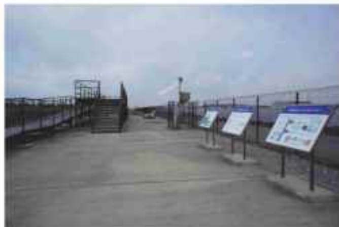
見学用の物見台と太陽光発電事業の概要を説明する看板を設置
