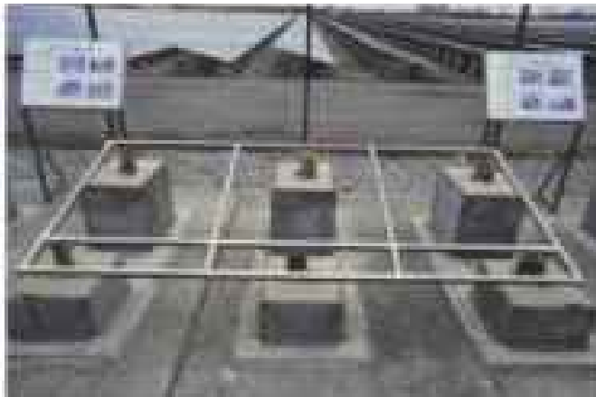
風の影響を考慮し基礎コンクリートにパネルを直接固定する方式を採用
