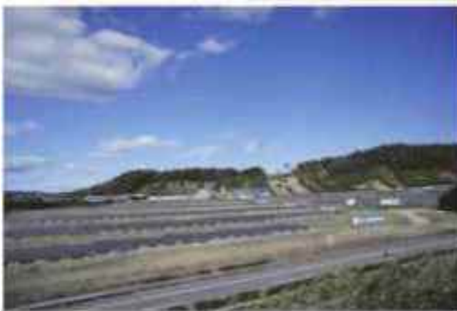
処分場の雑壇地形を有効活用し効率的にパネルを設置
