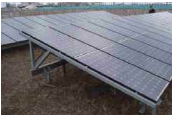
風の影響を考慮したパネルの設置
