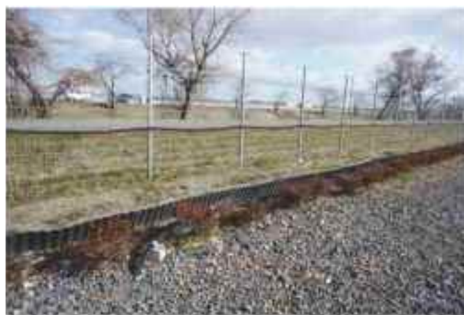
処分場の周囲に雨水誘導板を設置し樋管に雨水が流れるように工夫
