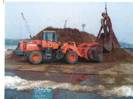
ホイールローダによる補助状況
