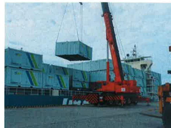
200トントラッククレーン
