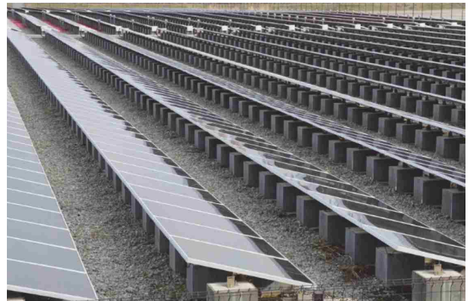
雑草繁茂対策として防草シートの敷設等を実施
