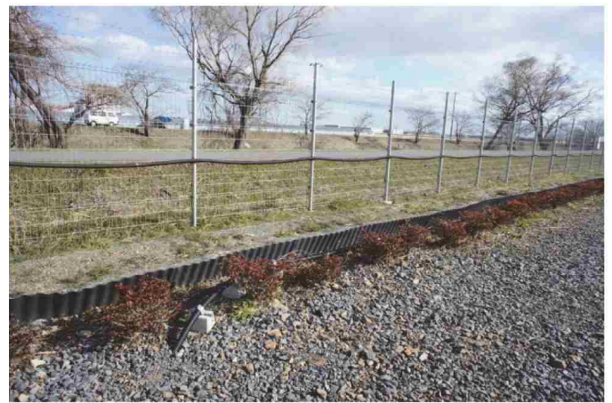
処分場の周囲に雨水誘導板を設置し樋管に雨水が流れるように工夫
