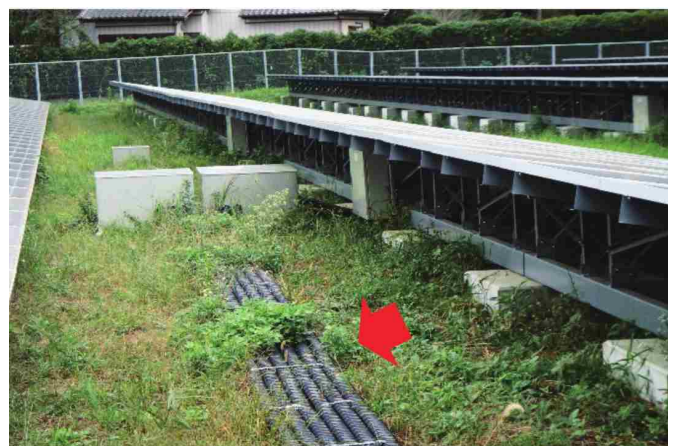
埋立物に影響を及ぼさないよう配線を地表設置のチューブ内に格納
