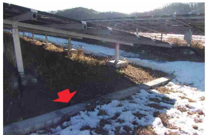
配線の劣化防止や県職員の維持管理作業効率向上のため配線を蓋付U字溝に収納
