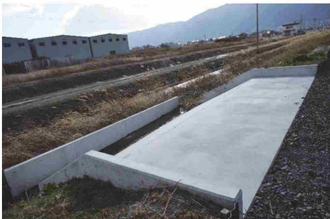
雨水は南側にある樋管から排出
