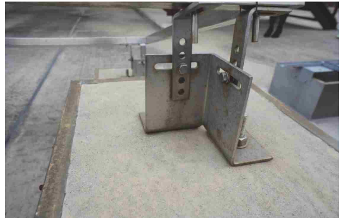
微調整可能な治具を設置
