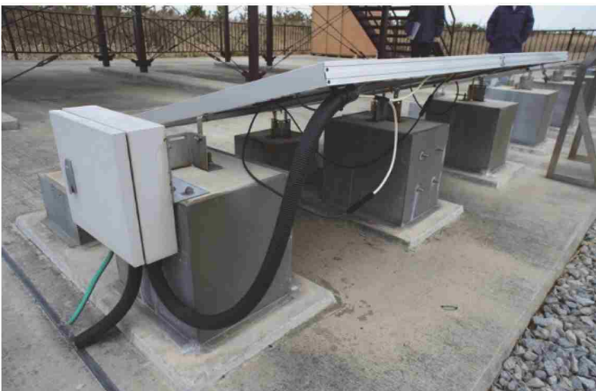
沈下に備えてパネルの位置を微調整できる治具を開発し使用
