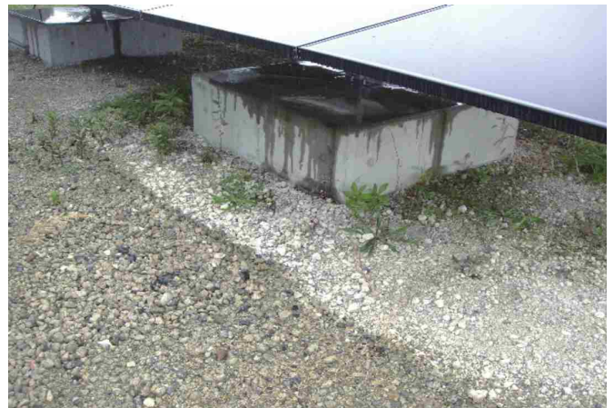
水捌けを考慮し、勾配をつけて碎石を敷設
