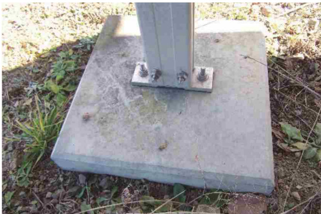
埋立物に影響を及ぼさないよう、掘削深度を500mm未満に設計
