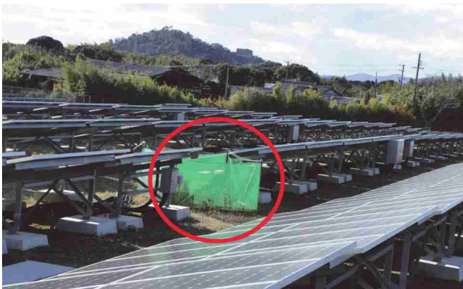
ガス抜き管等の処分場維持管理設備周辺に管理用スペースを確保
