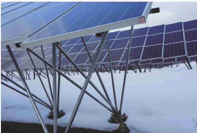
鋼管の打ち込みにあたり作業員はガス対策としてガス検知器を常備
