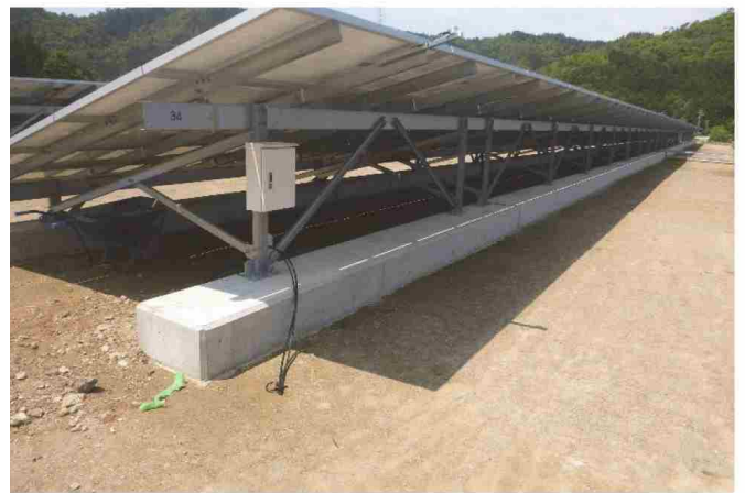
埋立物への影響と不等沈下に備えて連続式の基礎を採用
