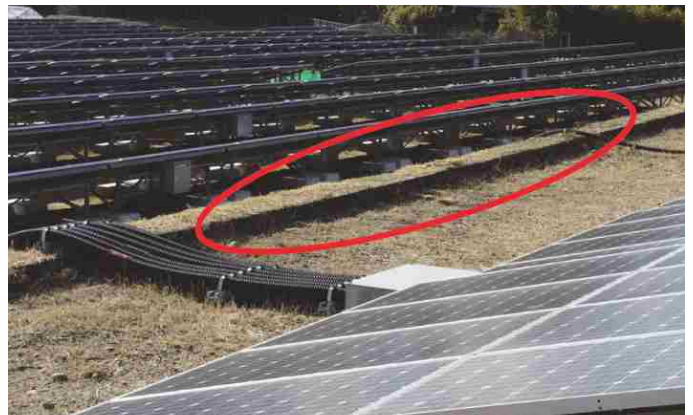
雨水による表土等の流出を防ぐため雑壇ごとに土堰堤を設置
