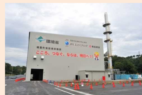
楢葉町の仮設焼却施設 (平成28年10月)
