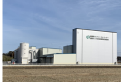
令和元年度本格稼働予定の カントリーエレベーター
