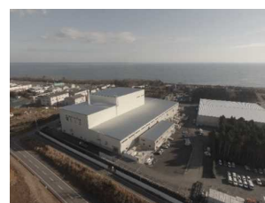
大熊町の仮設焼却施設
