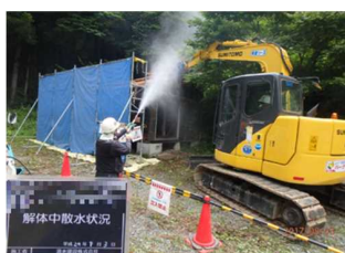
被災家屋等の解体の様子
