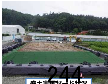
盛土実証ヤード状況
