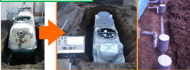
単独浄化槽撤去
