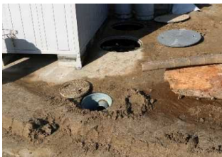
令和元年東日本台風における水害事例による浄化槽被害
