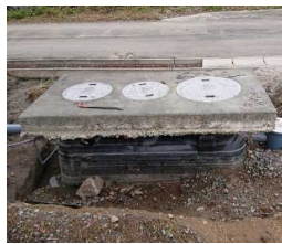
令和元年東日本台風における水害事例による浄化槽被害
