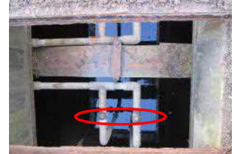
浄化槽の劣化(左:鋼管製バルブの腐食、右:塩ビ管の破損)
