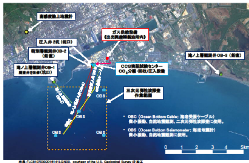
図2 苫小牧におけるCCS大規模実証試験設備
