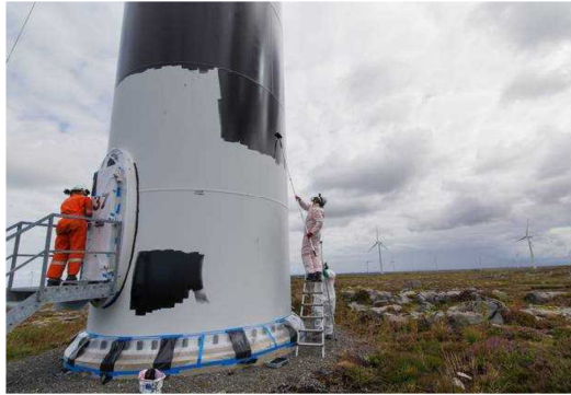
図-15 : ノルウェーにおける風車タワー下部への彩色の事例
