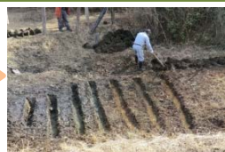
土砂堆積部分の浚渫
