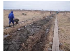
水抜き水路の埋め戻し
