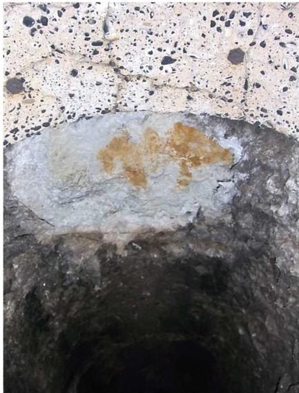
①煙突用石綿断熱材
