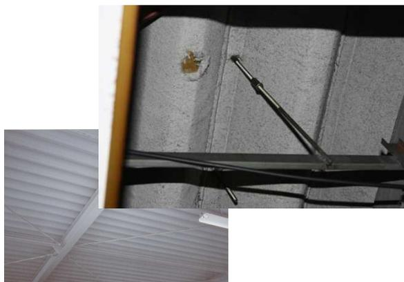
レベル2: 屋根用折板石綿断熱材
