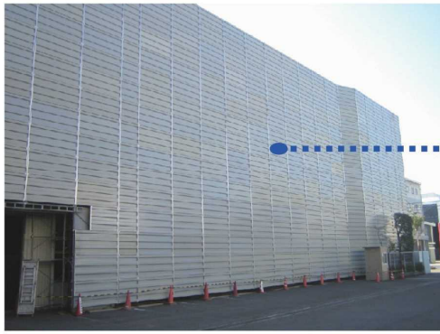
図 3.28 建屋周囲に設置した、通常の解体工事で使用する防音パネル（枠組足場に取り付け、内部の石綿除去工事を視覚的にも遮断）
