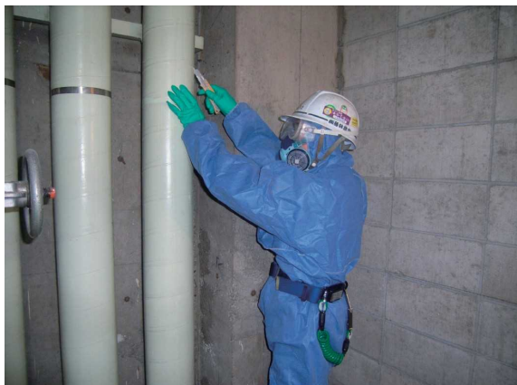
図 3.79 保温材被覆撤去
