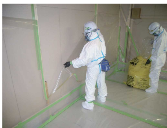
図 3. 72 養生シートの撤去
