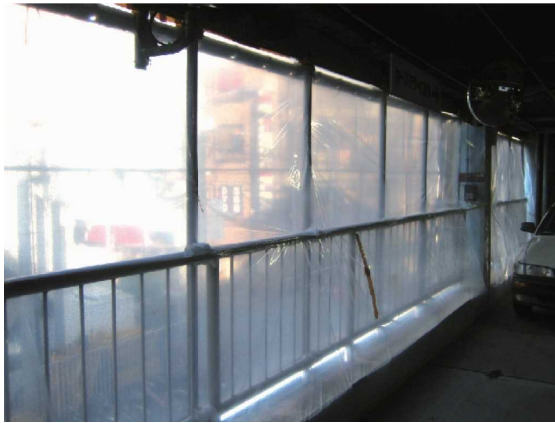
図 3.36 外壁の飛散防止措置例（外部側にメッシュシート張り，内部側に隔離用プラスチックシート張り）
