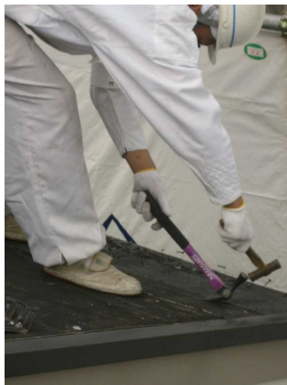
接合固定部分の取外し
