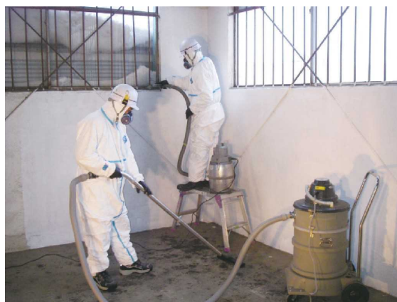
図 3.73 高性能真空掃除機を用いた作業場内の仕上げ清掃
