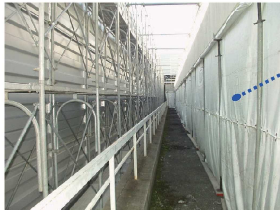
図 3.30 外壁開口部の飛散防止措置（開口部全面に防災シートを張った。詳細は図 3.32）
