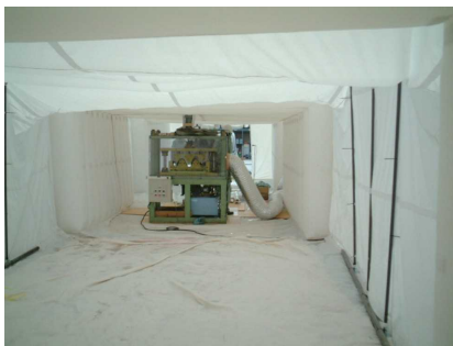
図3.103 吊りおろした折版を局所排気装置付切断機で切断するための切断ブース
