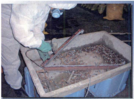
図 3. 118 掻き落とし除去作業の例
