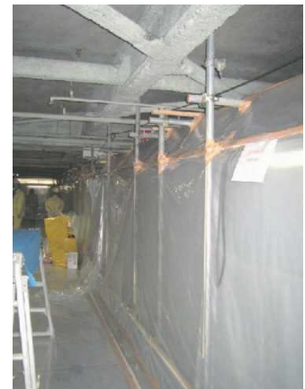
図 3. 16 同上施工区画(内部側、右外側が車路)
