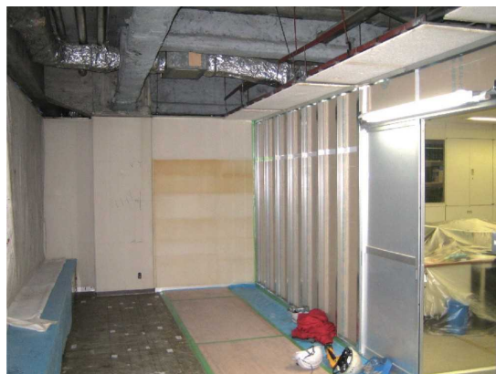
図 3.12 テナントビルの施工区画（内部側）
