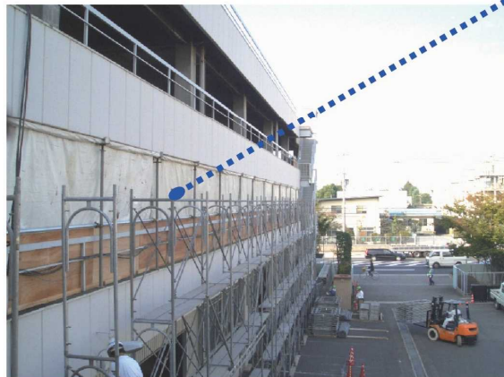
図 3.29 外壁開口部の飛散防止養生（既存手すりを活用し、防災シートとベニヤ板を使用して隔離の破損を防止。）
