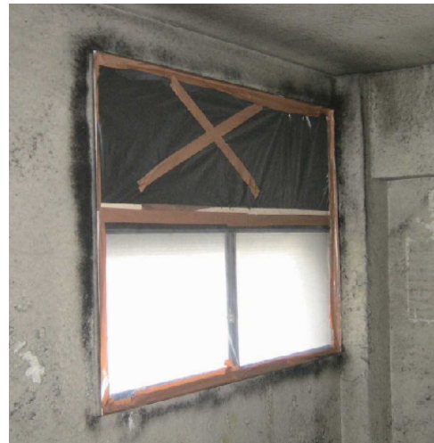
図 3. 27 窓、換気口の養生例
