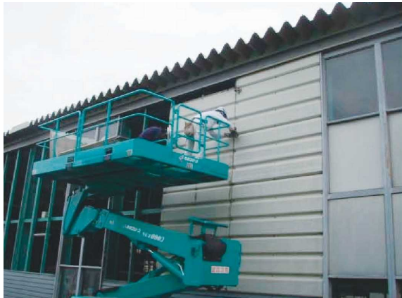
壁金物取外し
