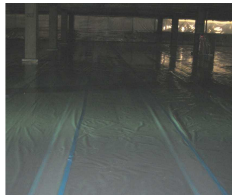
図 3.24 床面の隔離養生例（2重張り）
