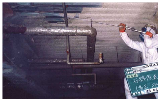
図 3.56 ウォータジェット工法の例
