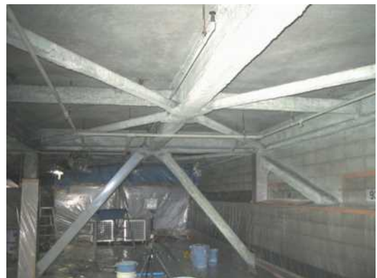
図 3. 15 同上施工区画の内部側
