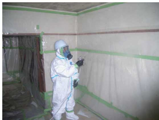
図 3. 71 隔離・養生シートへの粉じん飛散防止剤の散布
