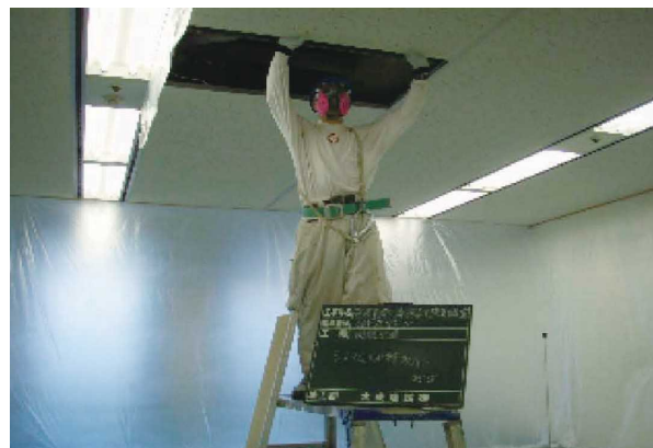
図 3.110 天井石綿含有成形板の除去例
