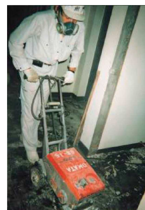
図 3.114 石綿含有ビニルタイルの除去例
