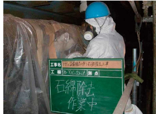
図 3.97 石綿除去作業中 1
