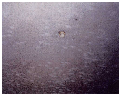
（吸音・断熱材：機械室の壁・天井）
