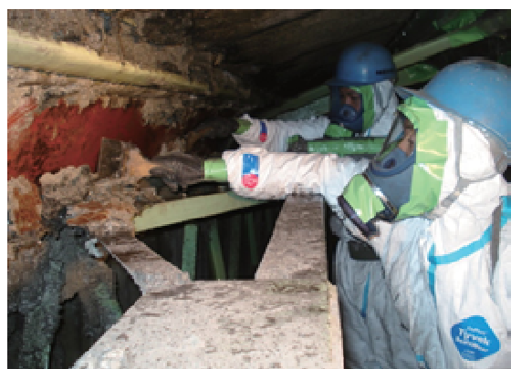
図 3.64 手工具（ヘラ）を使用した石綿含有吹付け材の除去作業
