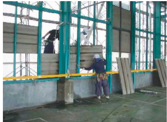
壁石綿含有成形板取外し
