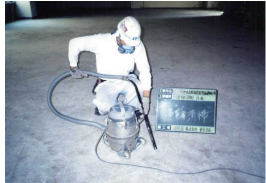
図 3. 115 清掃 高性能真空掃除機使用例
