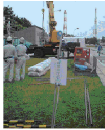
図 3.102 折版をプラスチックシートで梱包後、クレーンで吊りおろしたところ
