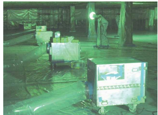
図3.52 集じん・排気装置への排気ダクトの取付け
