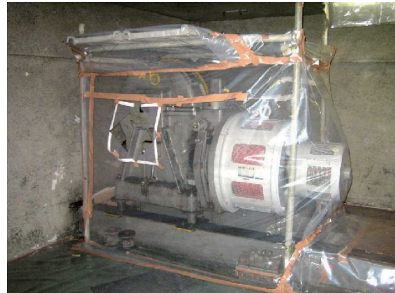
図 3.39 作業場内部の養生例（エレベータ機械：接触防止用に布板敷き，発生熱を放散させる小窓を設置）
