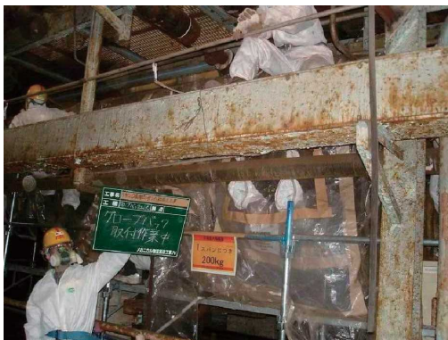
図 3.96 特殊グローブバッグ取付作業中
