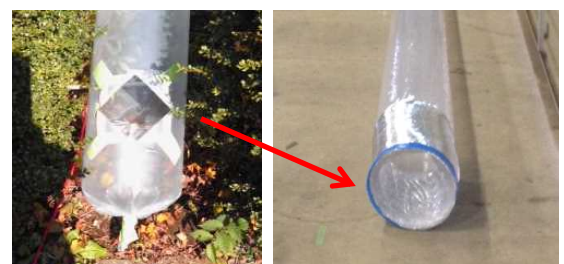
図3.53.2 排気ダクトの例
