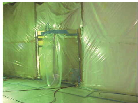
図 3.26 壁面の隔離養生例 （作業場内側 負圧化のため内側へはらんでいる）
