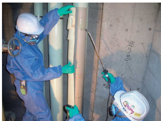
図 3.80 保温材の取外し
