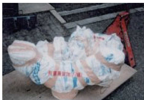
図 3.84 除去した保温材付配管を梱包，特別管理産業廃棄物として処理の例
