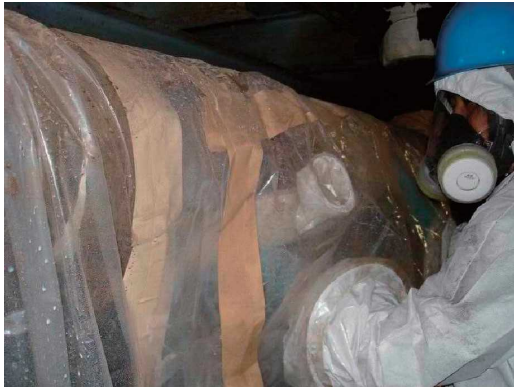
图 3.98 石棉除去作業中 2
