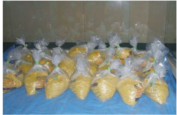
図 3.69 除去した石綿廃棄物の一時保管
