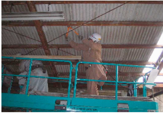
屋根スレート止め金物切断
