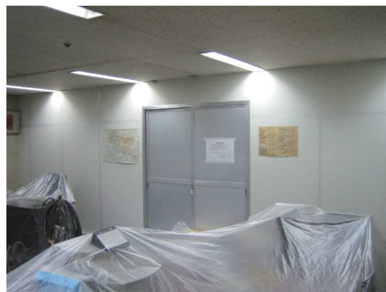
図 3.13 テナントビルの施工区画（外部側，仮設扉）
