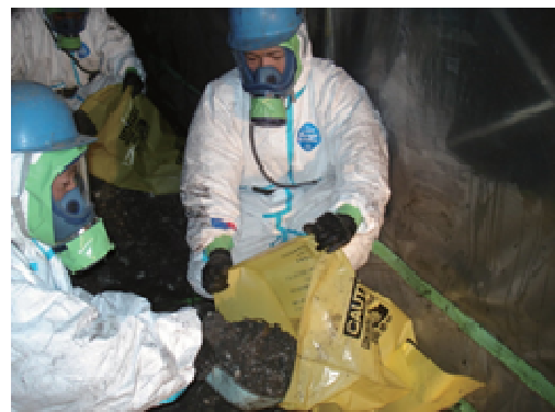
図 3.66 除去した石綿廃棄物の袋詰め（一重目）
