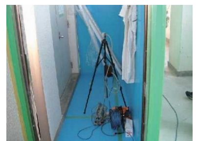
図 3. 18 同左施工区画(内部)
