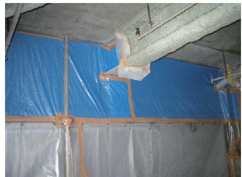
図 3.25 壁面の隔離養生例（作業場内側）
