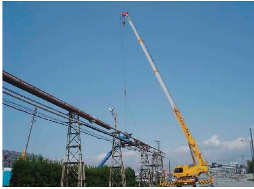
図 3.90 配管吊り降ろし
