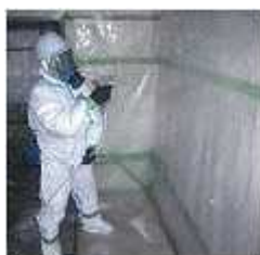
図 3.28 養生シートへの散布
