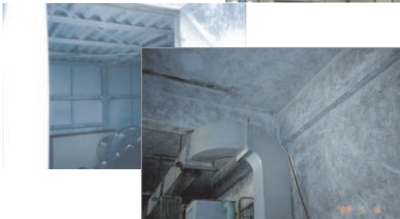
機械室の壁・天井、スラブ下・折板 屋根、階段裏・庇裏
