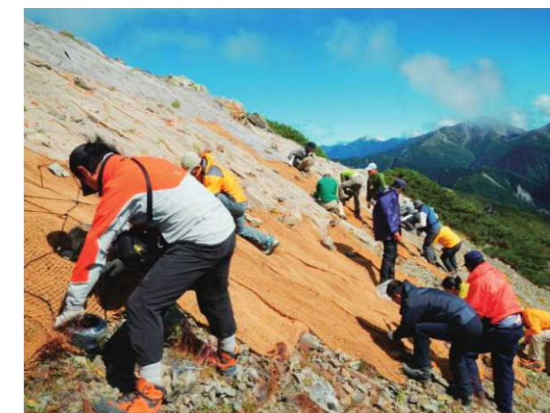
塩見岳の浸食防止マットの敷設作業
