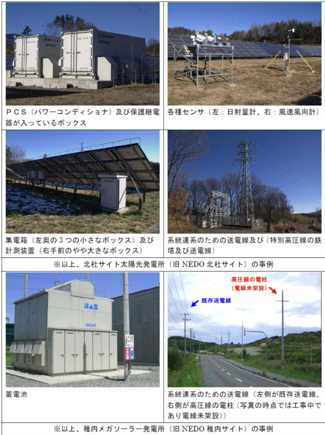
図 3.1-5 太陽光発電システムの構成要素の例
