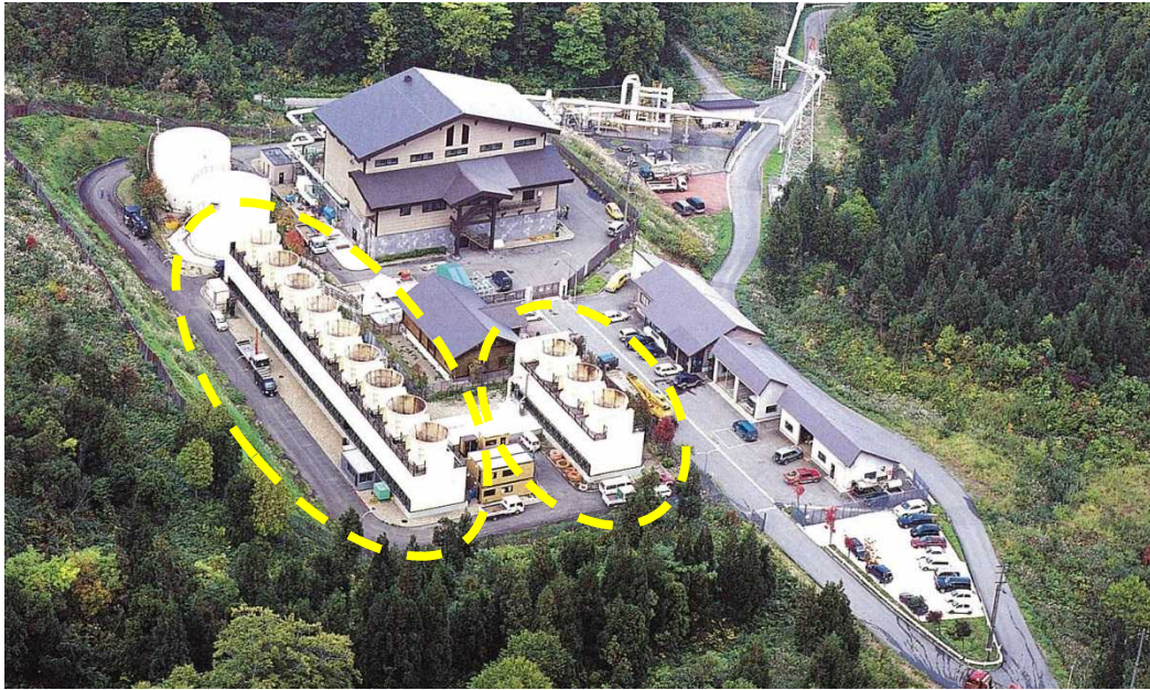
写真出典：東北電力(株)パンフレット
