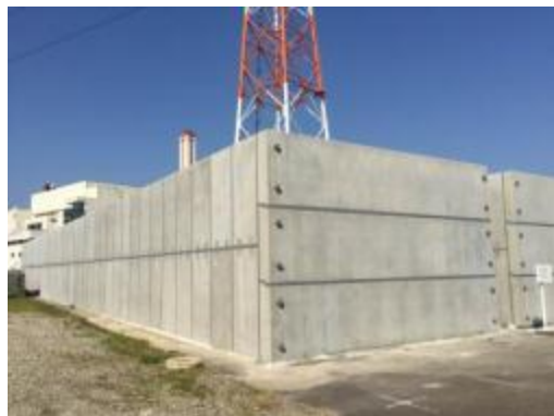
ボックスカルバートの設置
