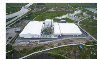
浪江町 仮設焼却施設
