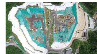
特定廃棄物埋立処分場
