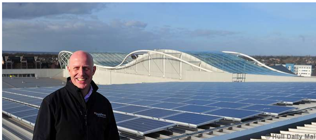
図 16-1 British Land の所有するショッピングセンターに設置されたソーラーパネル
