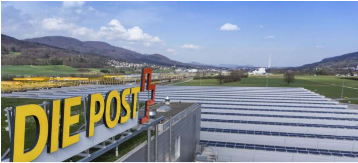
図 20-4 スイス・ポストの屋根上太陽光発電装置
