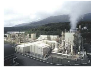
八丈島の地熱発電所
