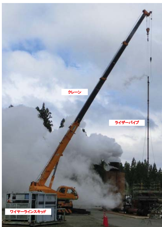
高傾斜検層ツールスによるプロダクション検層状況
