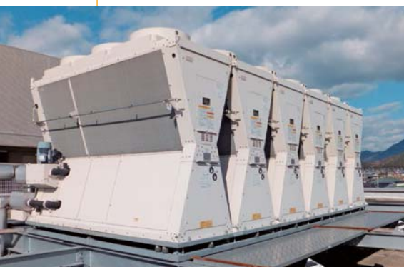
空調熱源の高効率化を実現する空冷ヒートポンプチラー
