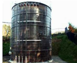
貯湯槽（保温前）
