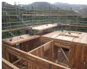
CLTを用いた施工例
